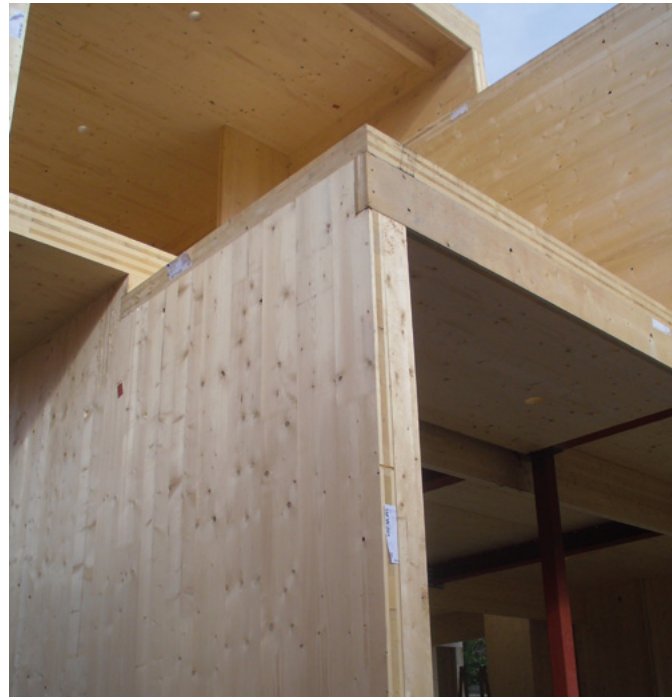
Estructura de fusta de CLT en habitatge unifamiliar
