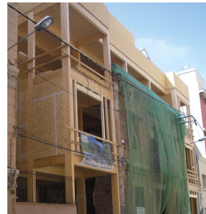
Estructura en entramat pesat en habitatge plurifamiliar a Barcelona
