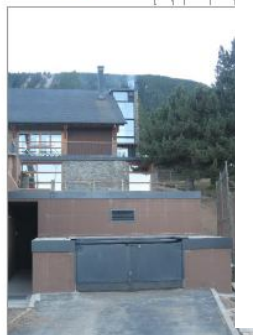
EDIFICI DE LA CALDERA DE LA BIOMASSA
