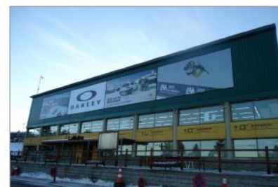
EDIFICI OFICINES / AUTO SERVEI / HANGAR TELECABINA
