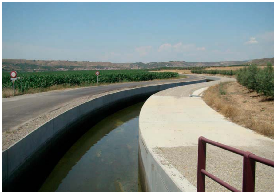
Tram en funcionament del Canal Segarra-Garrigues
