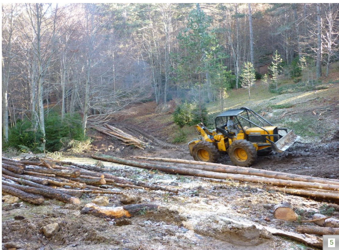
Detall d'actuació mecanitzada
