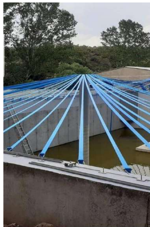
Detalls dels pilars i les cintes del Digestor.
